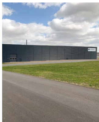
SP Mouldings nye lagerbygning i Stoholm
