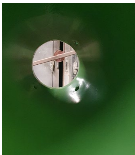
Rør belagt med Accopon HBA for god non-stick og nogen korrosionsbeskyttelse. Røret er en del af et anlæg, der fremstiller flokkuleringsmidler og koagulanter
