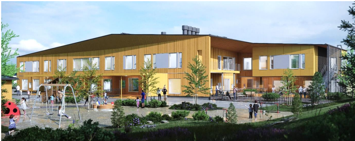
Espoo Kuurinkallio – Espoo (FI) Service community die zal worden opgeleverd in Q2 2024
