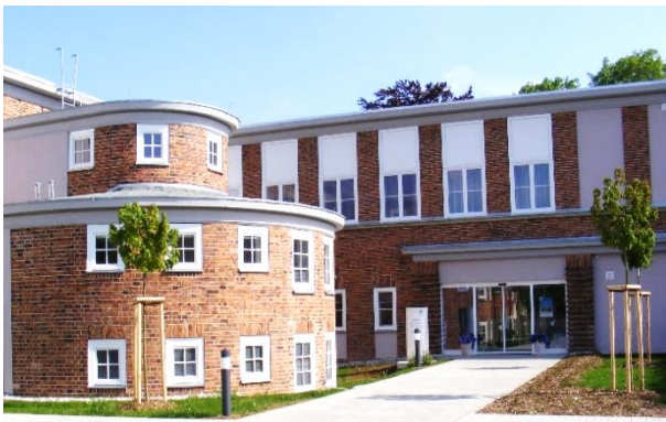
Azurit Seniorenzentrum Alte Zwirneri – Gersdorf (DE) Deel van de portefeuilletransactie van 19 woonzorgcentra in Duitsland, aangekondigd op 1 april 2021
