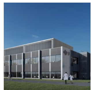
FYRISLUND 6:6, UPPSALA LABORATORIUM
