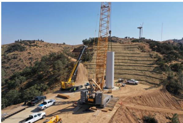
Byggnation av vindpark Wind Wall i Kalifornien, USA.
