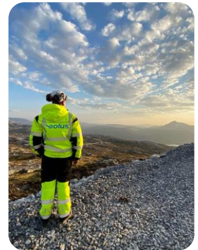
Byggnation i vindpark Öyfjellet i Vefsn kommun i Norge.
