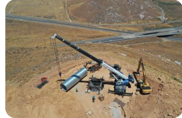
Byggnation av vindpark Wind Wall i Kalifornien, USA.
