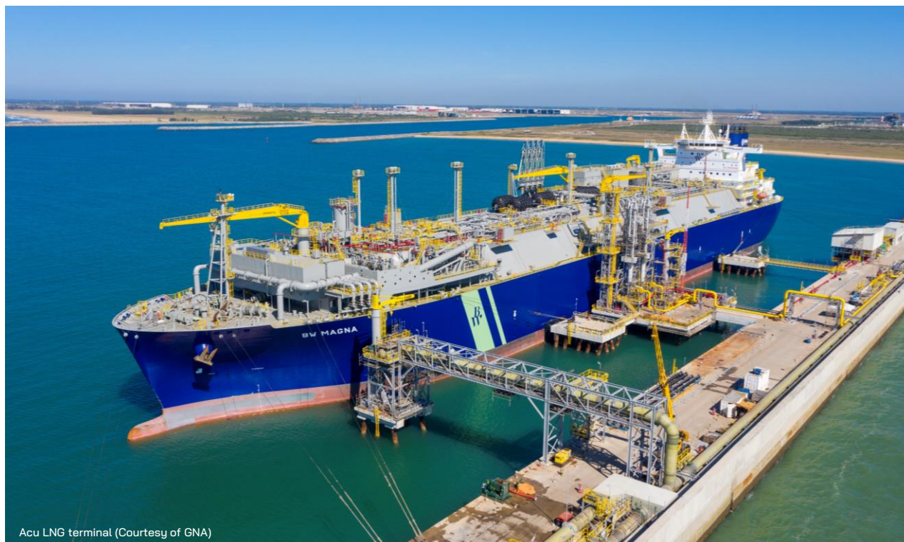
Acu LNG terminal (Courtesy of GNA)
