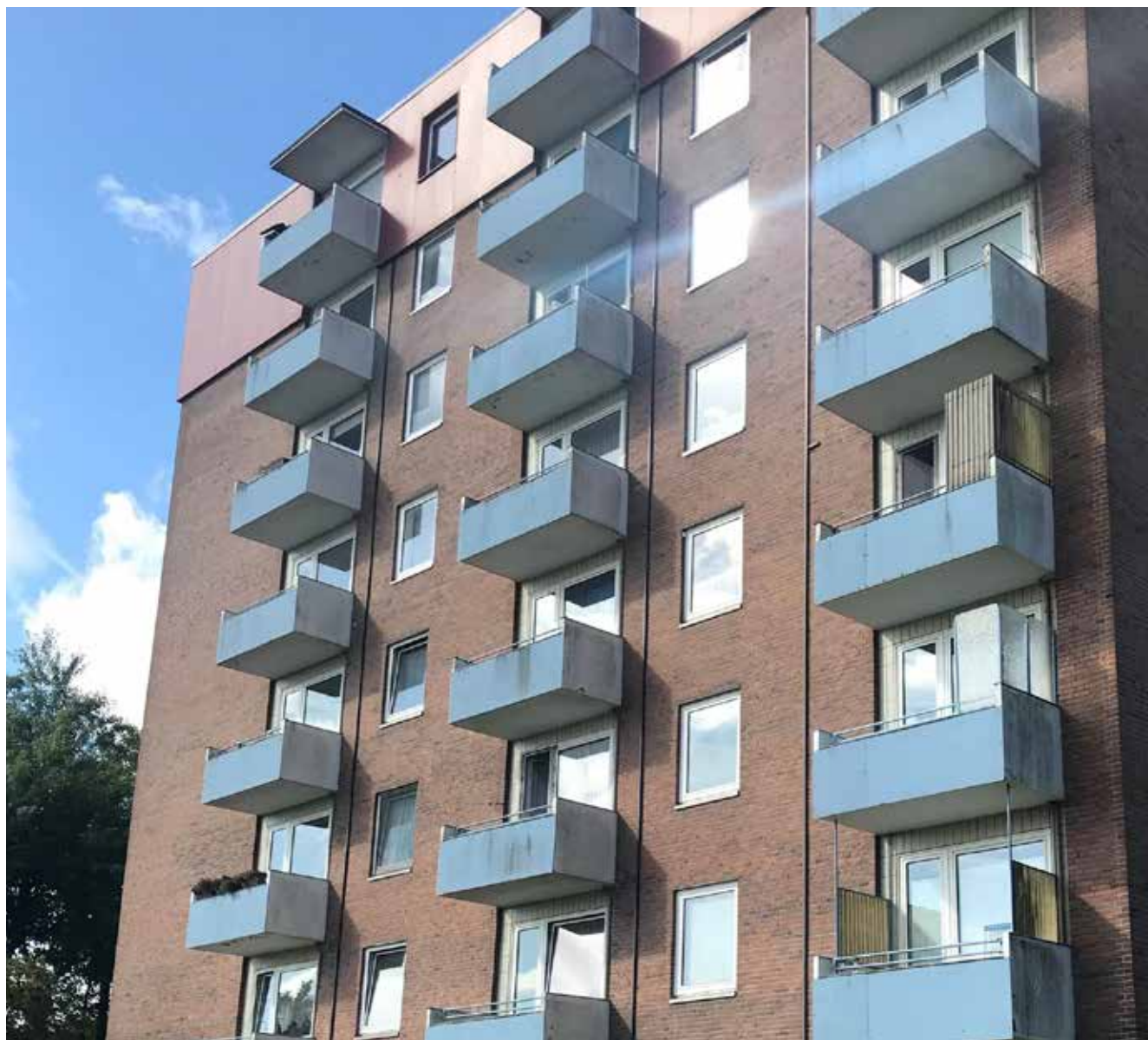
Erlanweg i Slesvig, renovering af altaner.
