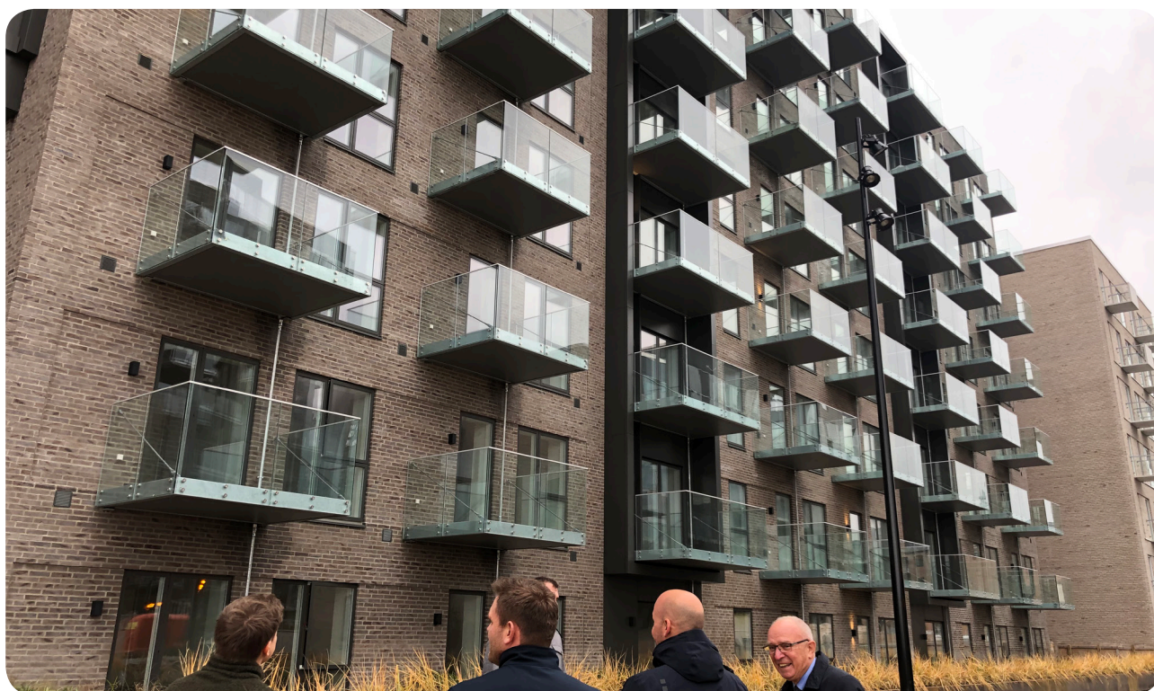
Beddingen 5, Østre Havn, Aalborg 6.100 m 2 udlejningsboliger der efter regnskabsperiodens udløb er afleveret til investor.
