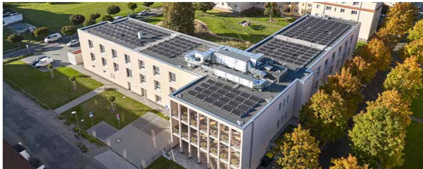
SENIORENHAUS LESSINGSTRASSE - WOONZORGCENTRUM IN WÜRZEN (DE)
