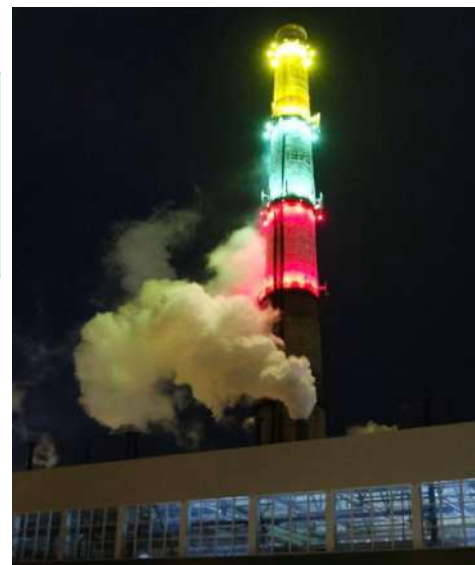
Chimney in Grigiškės
