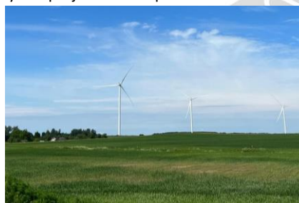
Anykščiai wind park turbines
