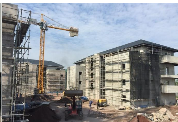
Bois Nobles construction site
