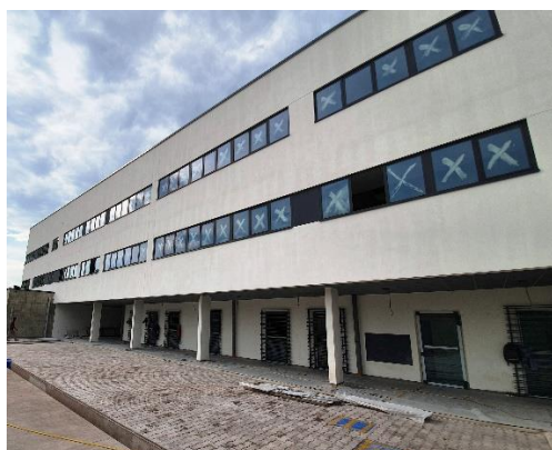
Petit-Pont construction site
