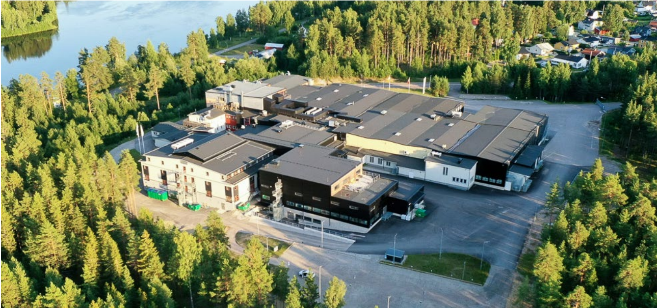
NorthX Biologics anläggning i Matfors.
