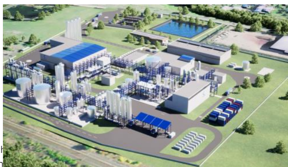
Abbildung 1: 3D-Modell der ersten kommerziellen PET-Biorecycling-Anlage von CARBIOS in Longlaville, Frankreich, die sich derzeit im Bau befindet und über eine Verarbeitungskapazität von 50.000 Tonnen pro Jahr verfügt.
