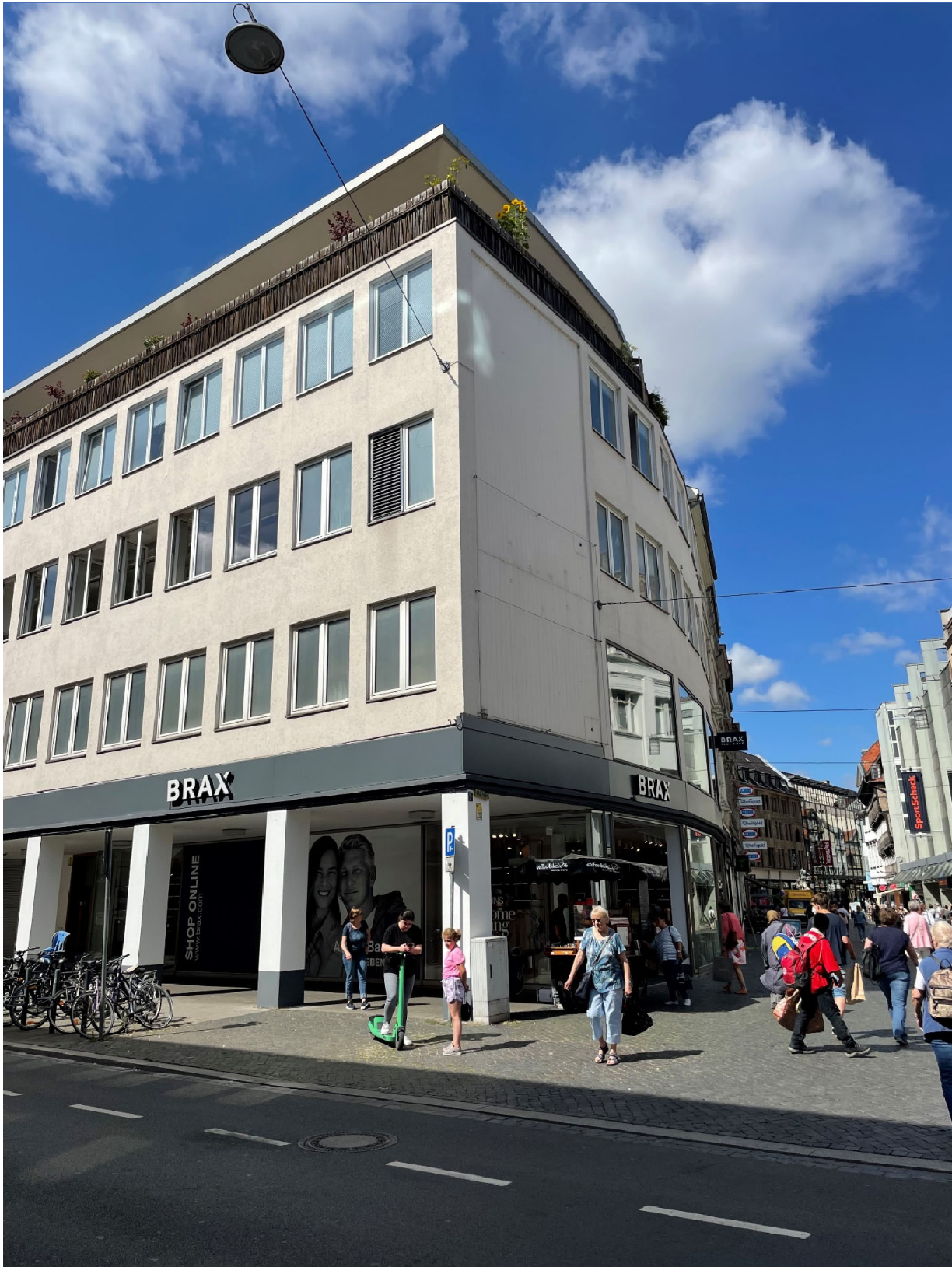
Ejendommen Braunschweig Münzstrasse
