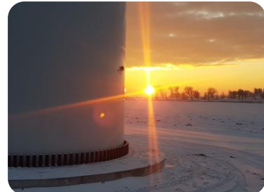
Vindpark Anneberg i Tidaholms kommun.
