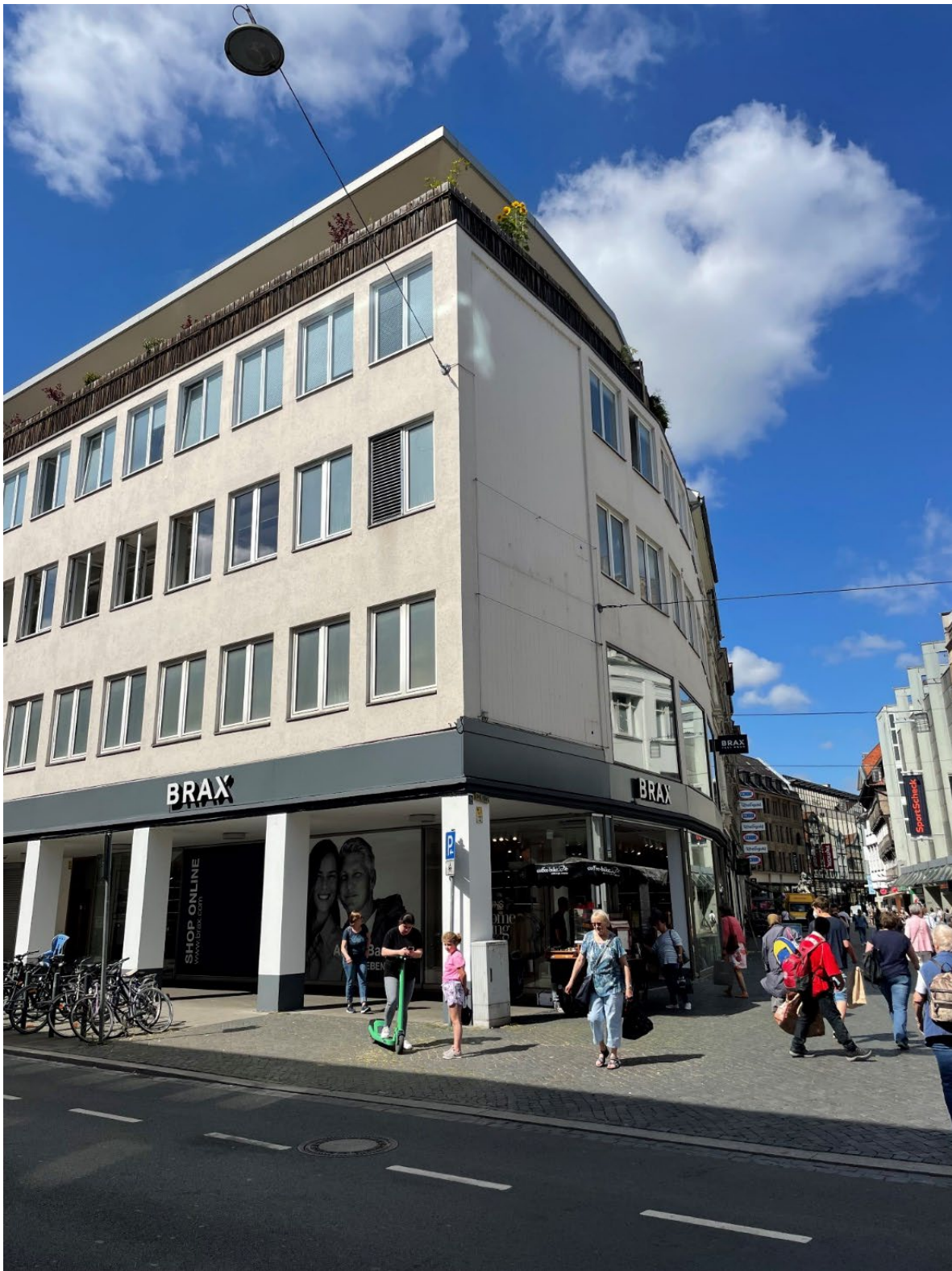
The property Braunschweig Münzstrasse
