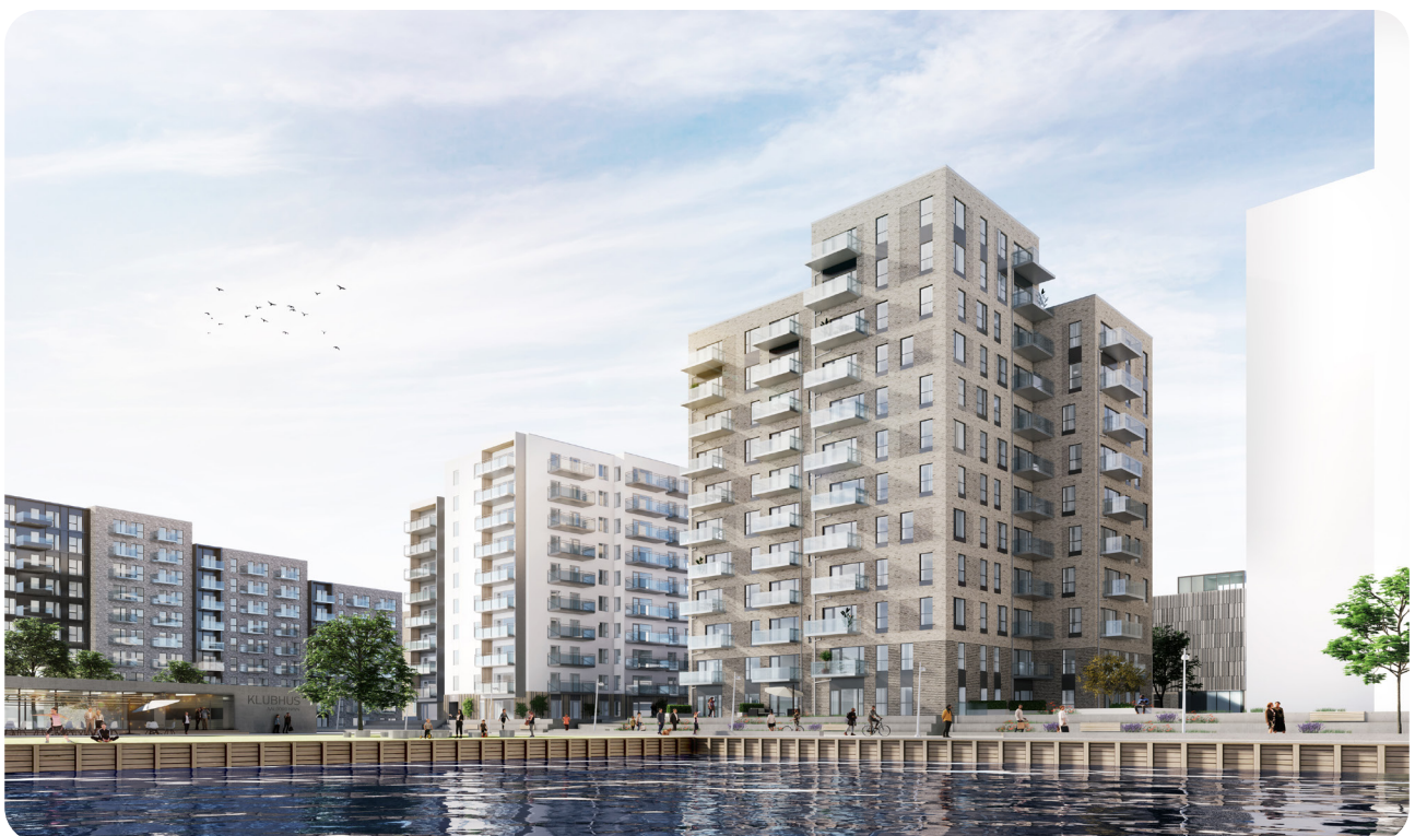
Havnehus 2, Østre Havn, Aalborg 5.675 m 2 udlejningsboliger under opførelse til privat investor.
