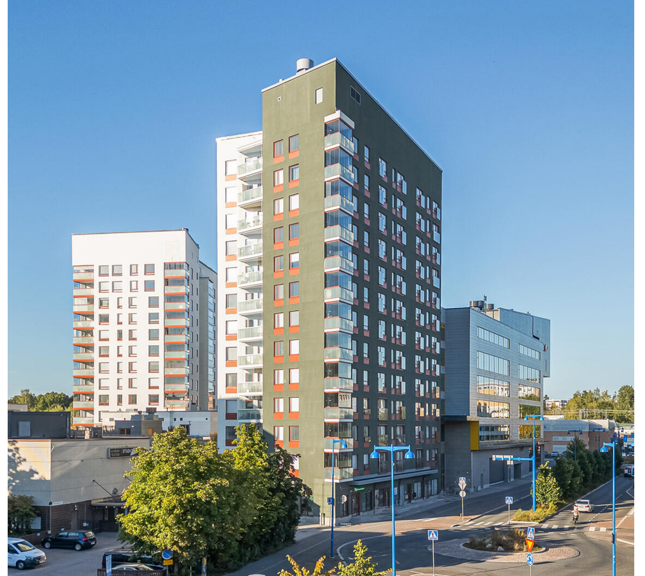
As Oy Järvenpään Basso, Helsingintie 14, Järvenpää
