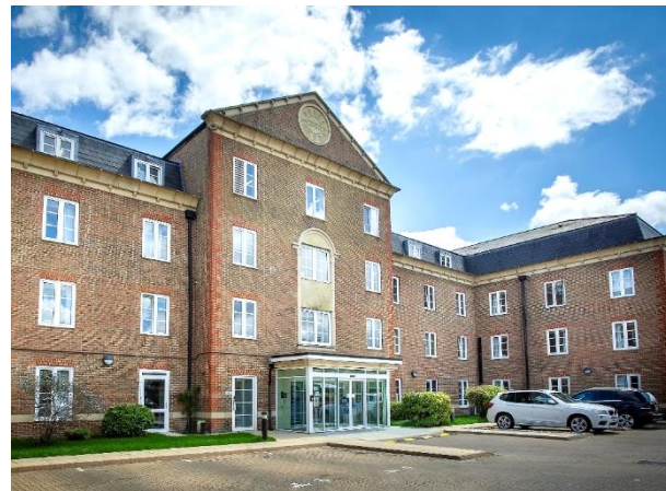
Rosewood House à Londres (UK) Maison de repos acquise en mars 2024
