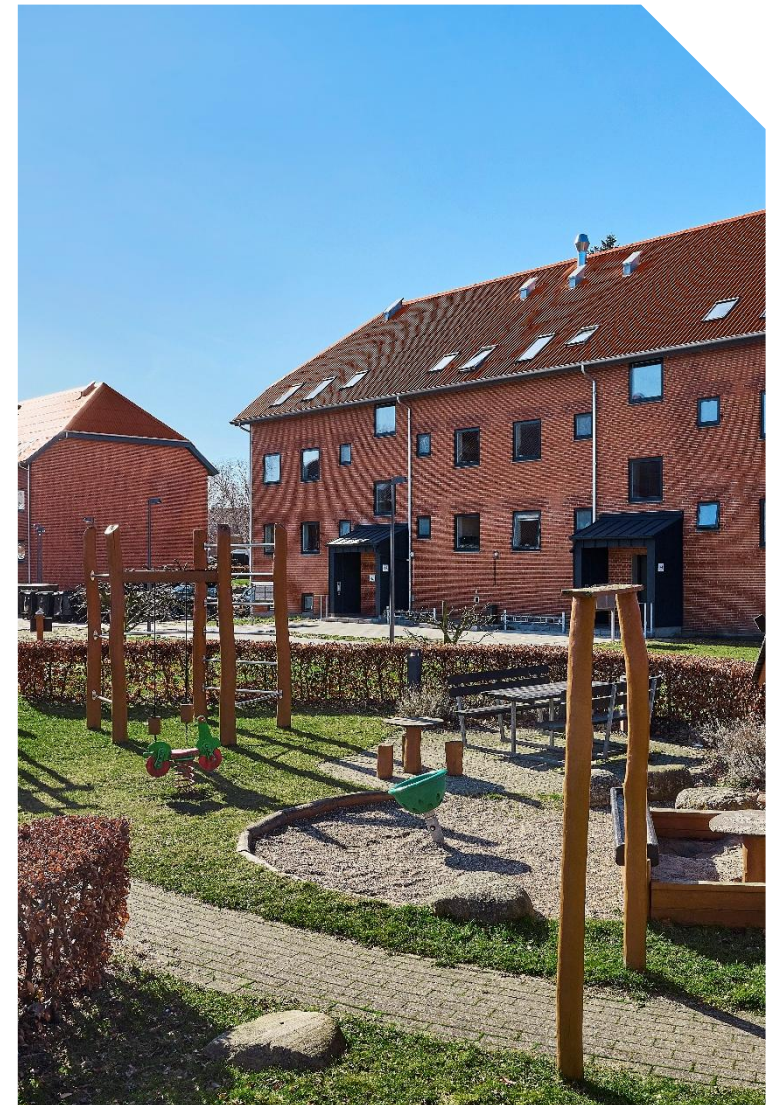
Apotekervænget – social housing refurbishment project in Sakskøbing – E&P.
