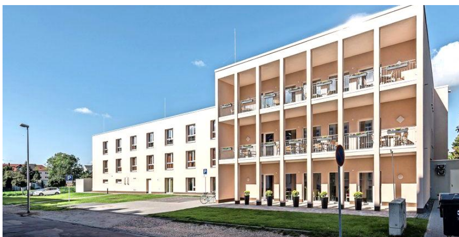
Seniorenhaus Lessingstrasse à Wurzen (DE) Maison de repos acquise en février 2022
