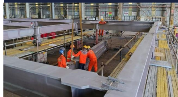
Assembly of Heat Recovery Steam Generator module (Kanfa)
