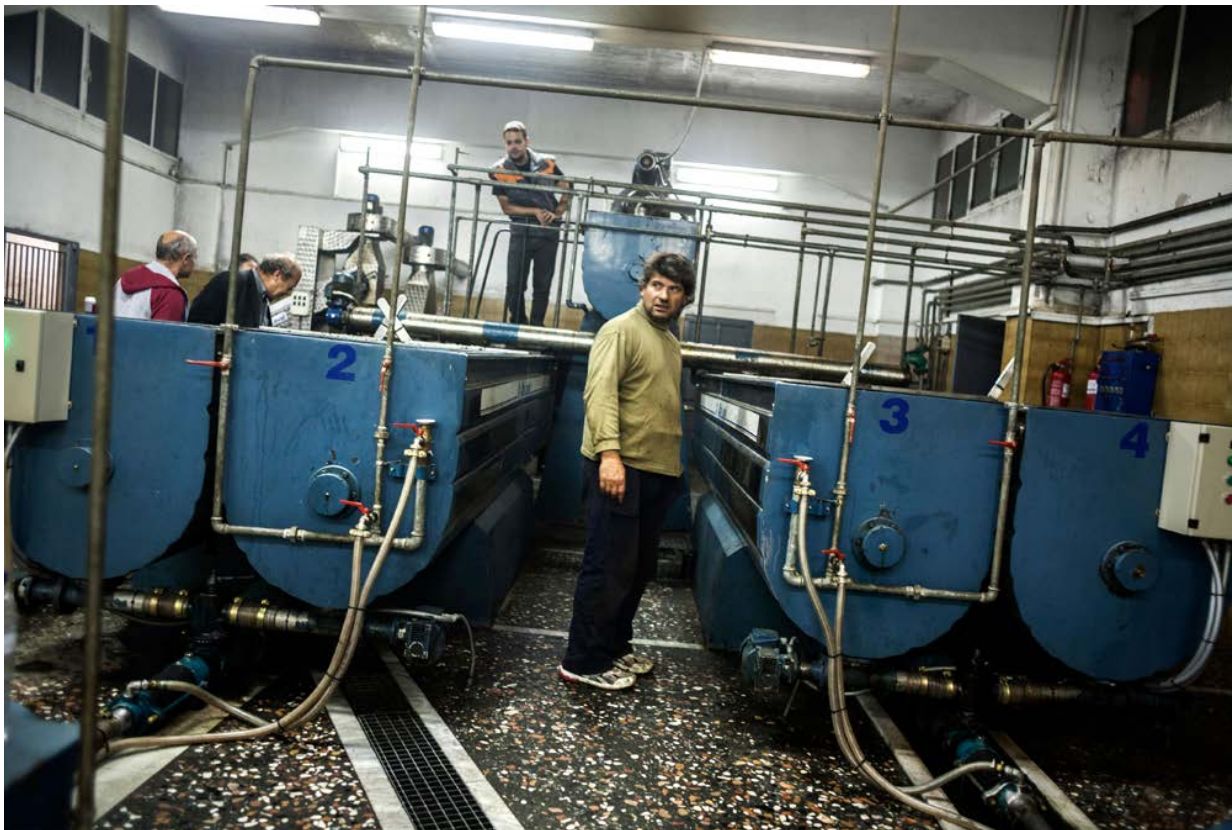
Extraktionslinje i Grekland med fyra utrustningar för malaxering. oliveCEPT kan minska behovet av malaxering med två tredjedelar, vilket kan finansiera en del av kostnaden för oliveCEPT vid nyinstallationer.
