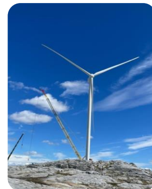
Montage av vindkraftverk i vindpark Öyfjellet i Vefsn kommun i Norge.
