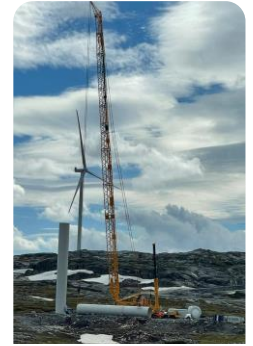
Montage av vindkraftverk i vindpark Öyfjellet i Vefsn kommun i Norge.
