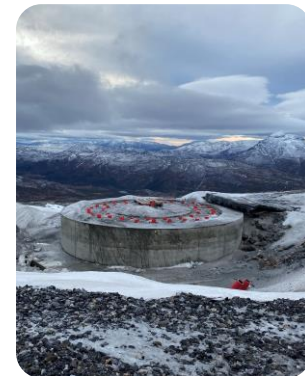
Gjutning av fundament i vindpark Öyfjellet i Vefsn kommun i Norge.
