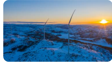
Vindpark Stigafjellet i Bjerkheim kommun i Norge.
