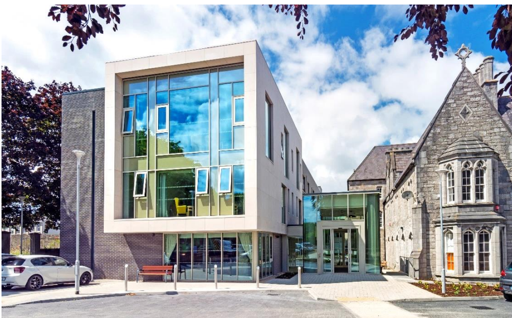
Clondalkin Nursing Home à Clondalkin (IE) Maison de repos achevée en juillet 2023
