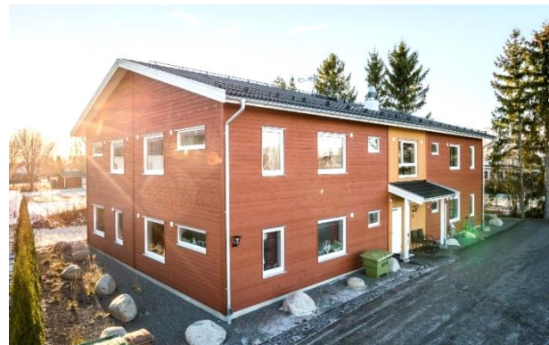
Bälinge Lövsta 10:140 – Uppsala (SE) Inclus dans la transaction de portefeuille de 16 centres de soins résidentiels spécialisés en Suède, annoncée le 24 juin 2021
