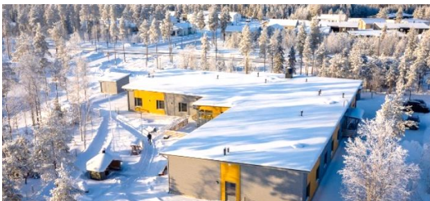
Kempele Ihmemaantie à Kempele (FI) Projet de développement achevé le 22 janvier 2021
