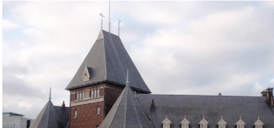
Toldboden/ Stejlt og højt tag, som på subtil og underspillet vis giver denne smukke Aarhusbygning karakter. Bygningen har for længst skiftet funktion fra dens oprindelige, men livet i den går videre, fordi dens kvaliteter ikke er at tage fra den.
