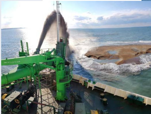
DEME > Travaux de dragage au Moyen-Orient
