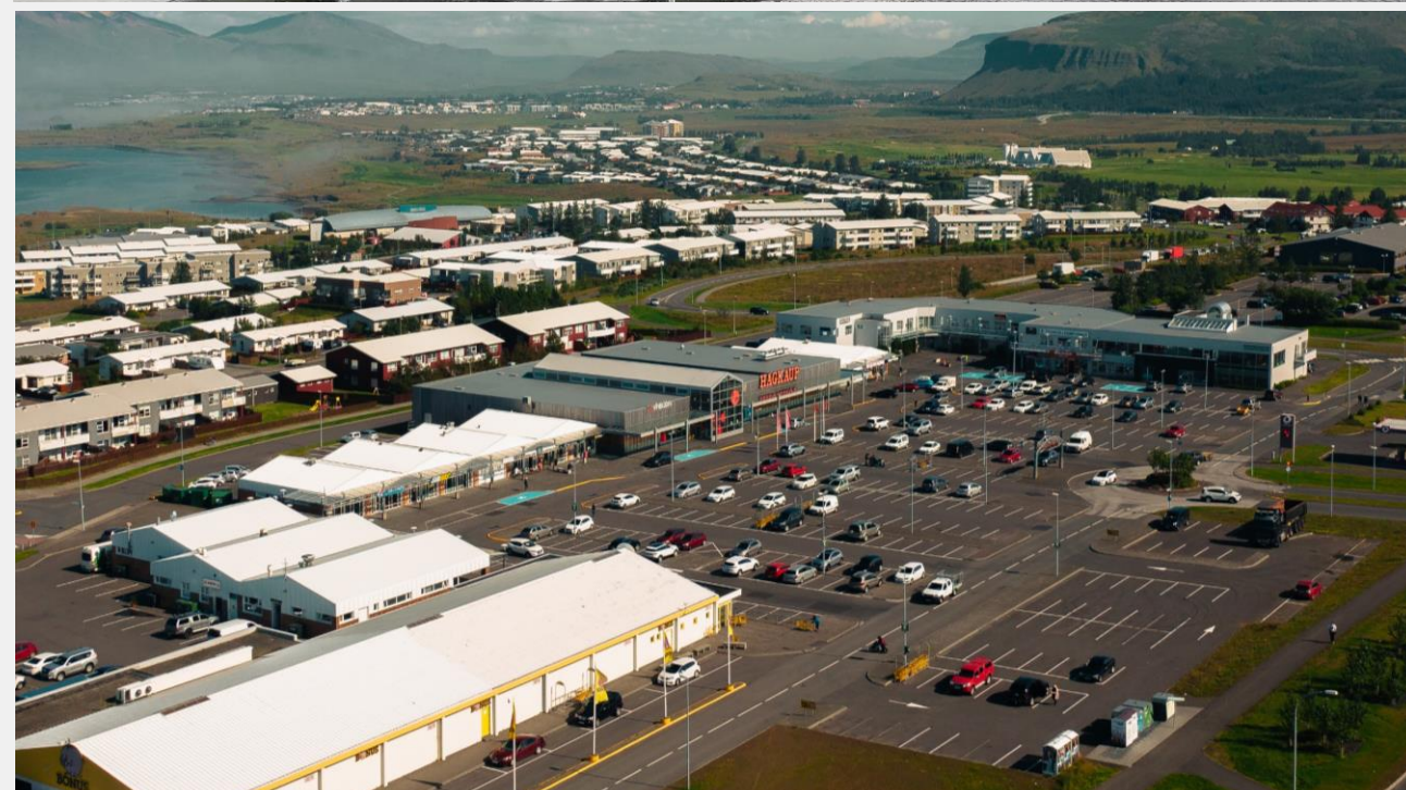
Stækkun vöruhúss Aðfanga á lokastigi framkvæmda
