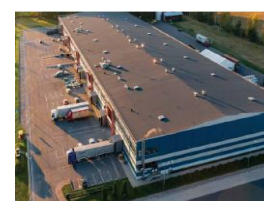
„Dommo business park“ Riga Latvia
