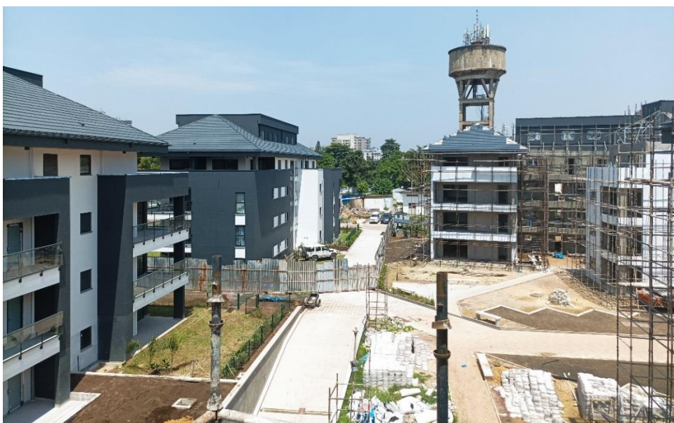
Chantier Promenade des Artistes
