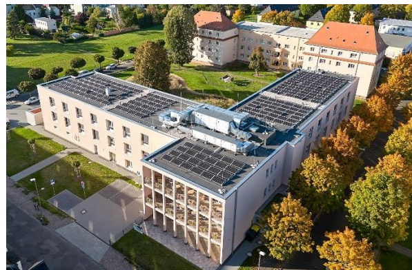
Seniorenhaus Lessingstrasse in Wurzen (DE) Woonzorgcentrum voltooid in februari 2022
