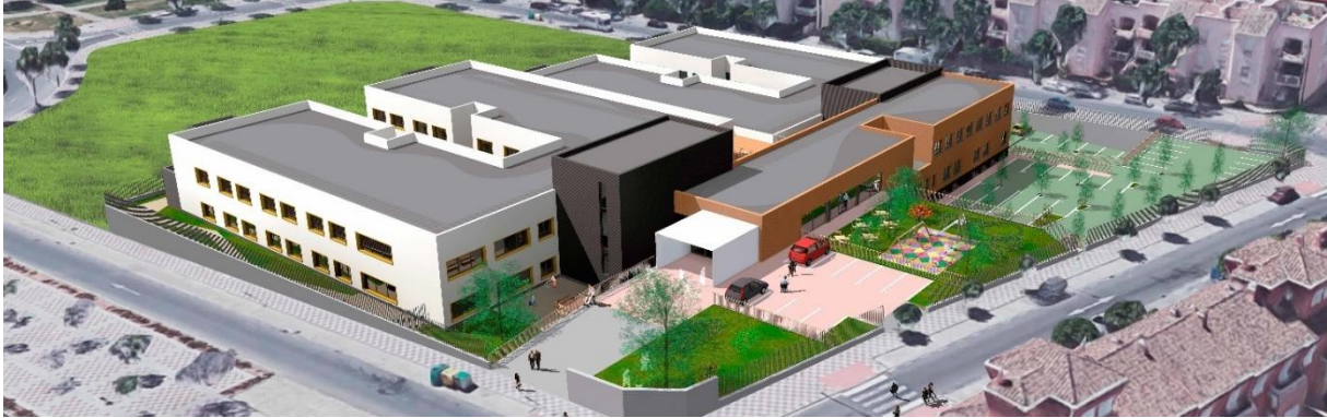
Tomares Miró in Tomares (ES) Woonzorgcentrum dat wordt opgeleverd in Q1 2024
