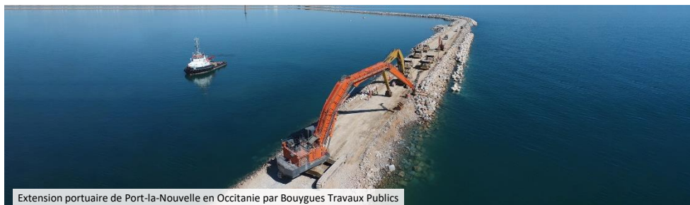
Extension portuaire de Port-la-Nouvelle en Occitanie par Bouygues Travaux Publics
