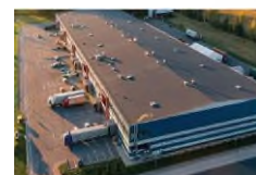
„Dommo business park“ Riga Latvia
