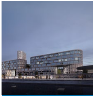
MÅLARPORTEN, VÄSTERÅS OFFICE/RESIDENTIAL
