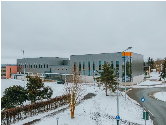
Ülenurme Gümnaasiumi spordihoone (teostaja: Embach Ehitus OÜ, foto: Timo Arbeiter)
