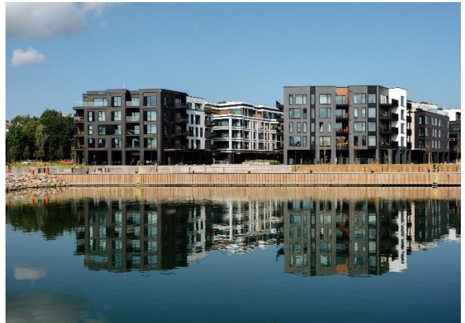
Kalaranna kvartal, I-II etapp (teostaja: Nordecon AS, foto: Tõnu Tunnel)
