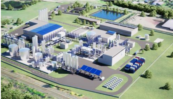
Abbildung 3: 3D-Modell der ersten kommerziellen PET-Biorecycling-Anlage von CARBIOS in Longlaville, Frankreich, die sich derzeit im Bau befindet und über eine Verarbeitungskapazität von 50.000 Tonnen pro Jahr verfügt.
