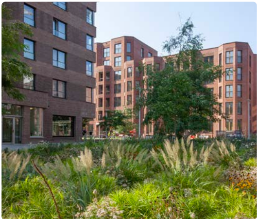
Nextensa • Fase II van het Park Lane-project op Tour & Taxis, Brussel
