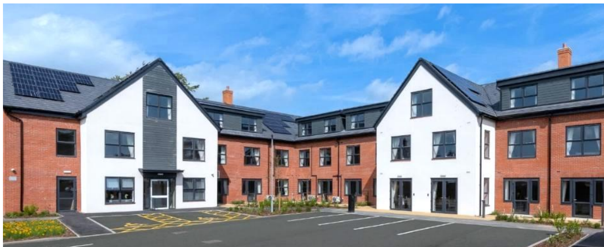
Beechwood Care Centre – Bridlington Woonzorgcentrum verworven in juli 2026
