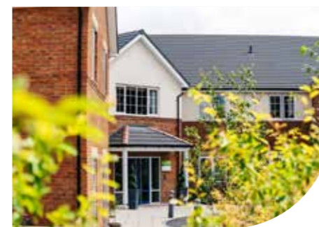
MAPLE COURT - MAISON DE REPOS À SCARBOROUGH (UK)
