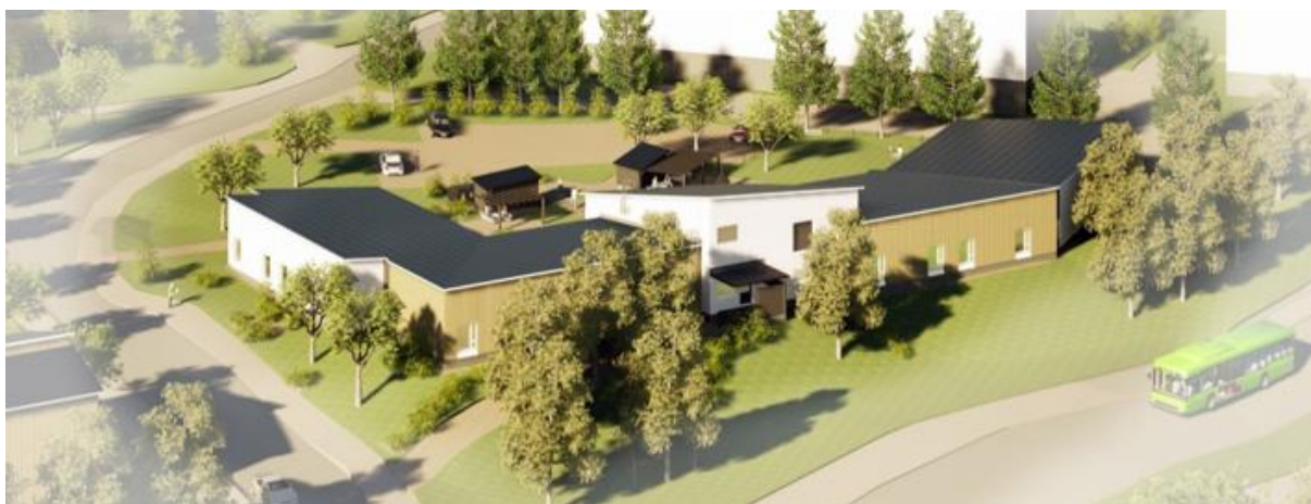
Jyväskylä Linnantie à Jyväskylä (Finlande) Centre de soins résidentiel pour personnes handicapées à achever pour Q2 2027
