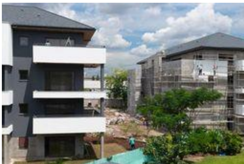
Chantier « Bois Nobles »
