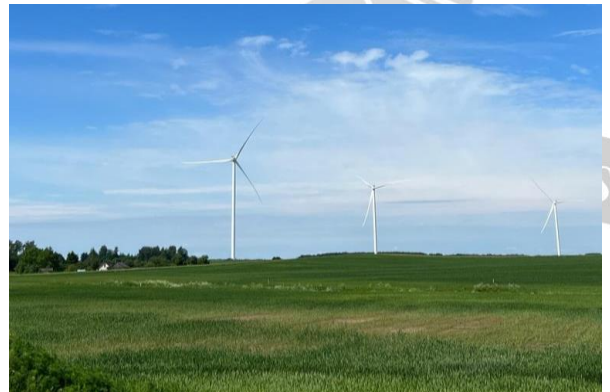
Anykščiai wind park turbines
