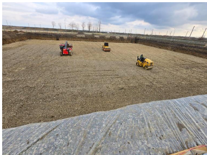
Det forberedende arbejde er i fuld gang. Der er gravet et 50 x 50 meter hul på fire meter i dybden til fundamentet, der skal bære de fire nye siloer, der hver kan rumme 6.000 tons.
