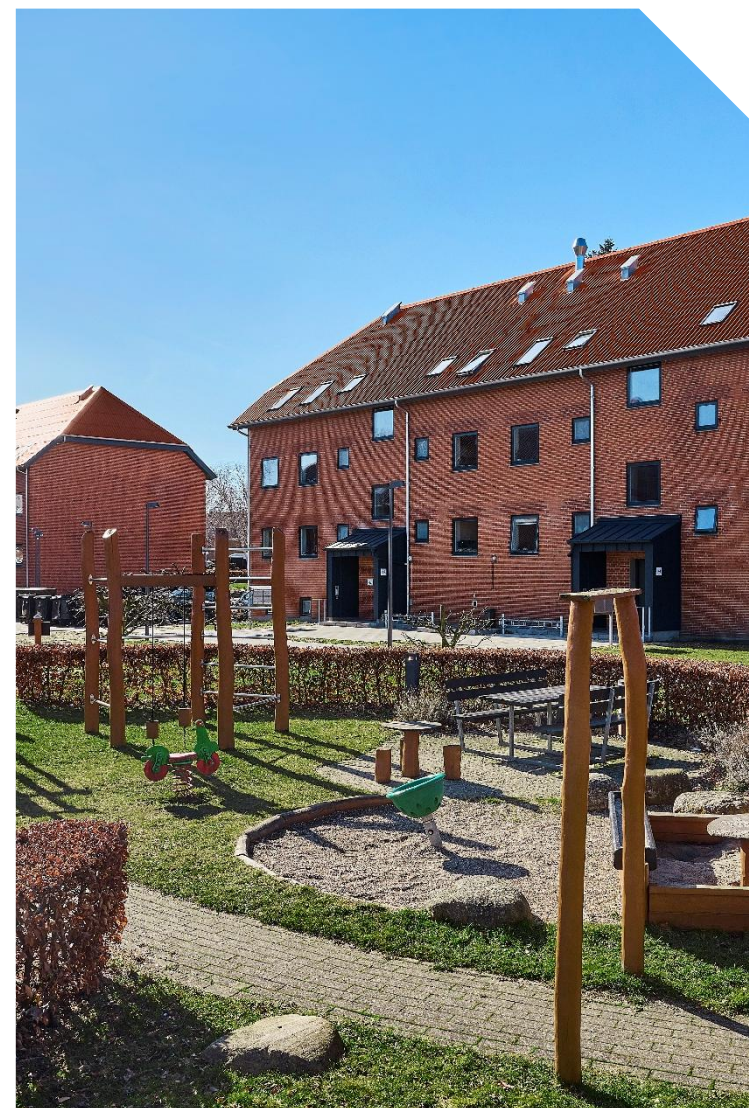
Apotekervænget – almen renovering i Sakskøbing – E&P.
