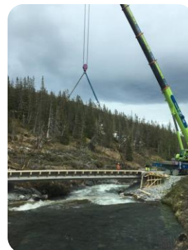
Byggnation av bro i vindpark Öyfjellet i Vefsn kommun i Norge.
