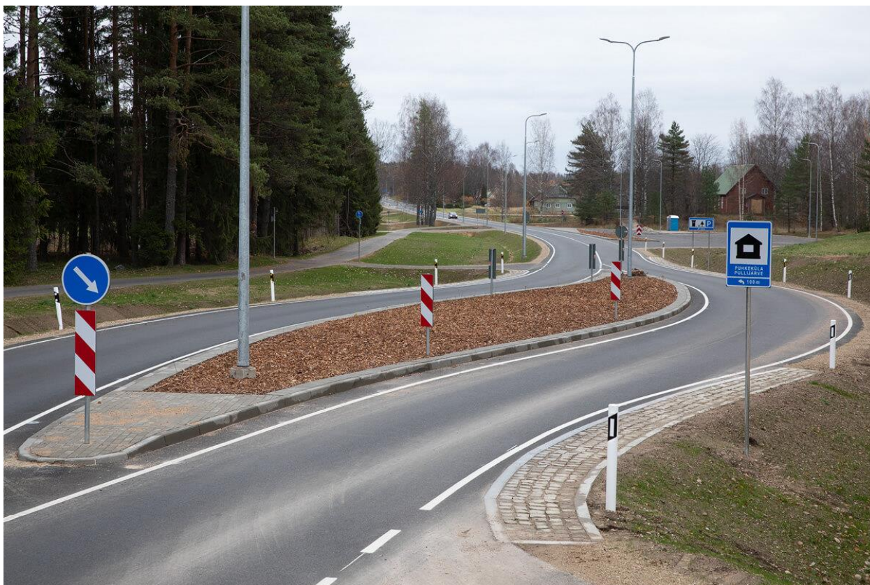
Põhimaantee 7 Missokülä-Hindsa rekonstrueerimine. Nordecon AS
