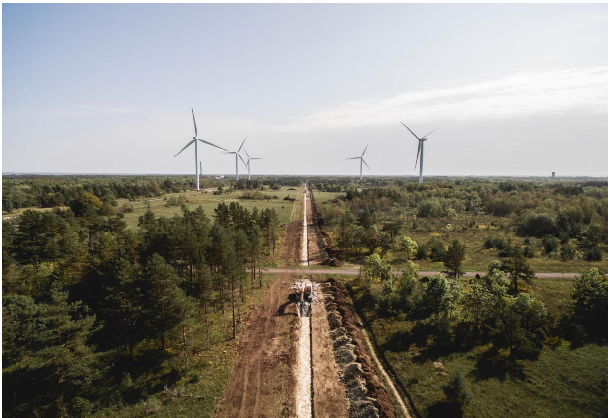
Kiili-Paldiski DN700 MOP54 gaasitoru pinnasetööd. Kaurits OÜ
