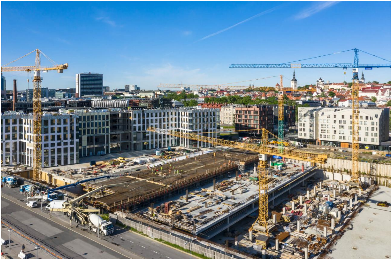
Ehitustööd Porto Franco objektil. Nordecon AS, Nordecon Betoon OÜ
