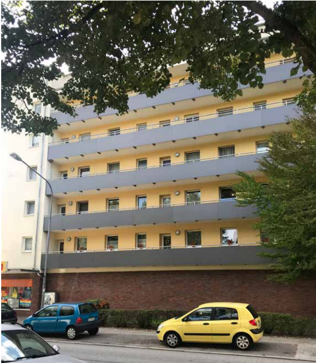
Marliring Lübeck, Nye facader og svalegange og balkoner.
